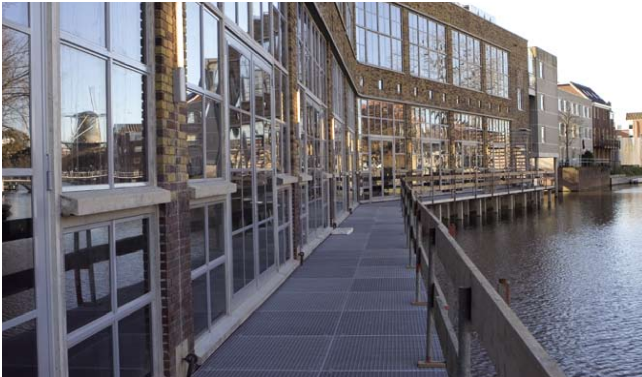
Nieuwe Energie in Leiden biedt onderdak aan bedrijven uit de communicatiesector, daklozenopvang en het Portaalkantoor.
